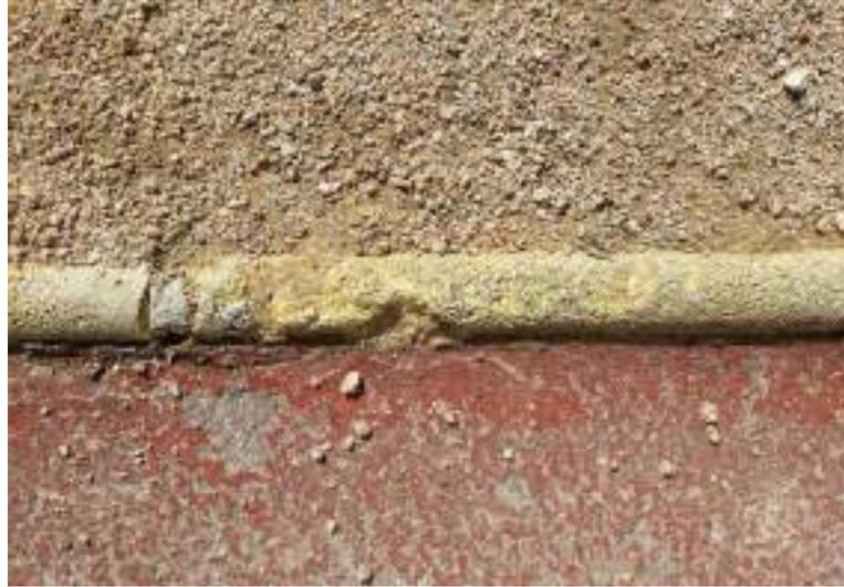
Bordillos con daños y deterioro debido a las inclemencias climáticas y al paso de vehículos de mantenimiento.
