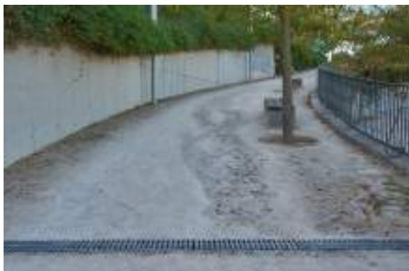
*Presencia de regueros provocados por la erosión en la margen sur de la zona temática (Terrazas Mesopotámicas y Terrazas Árabes), donde los viales adquieren pendientes excesivas.*
