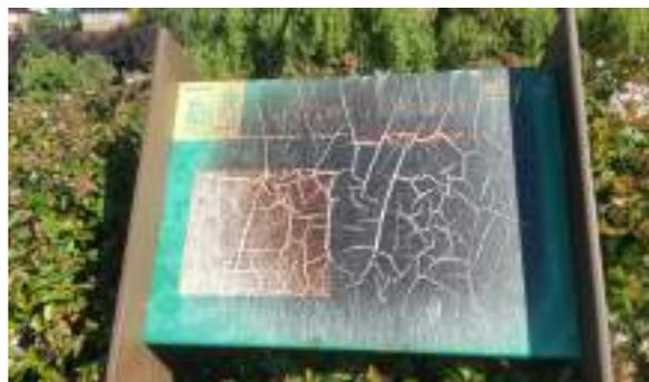
**Cartelería en mal estado debido a su mala ubicación con respecto a la incidencia de la radiación solar.**
